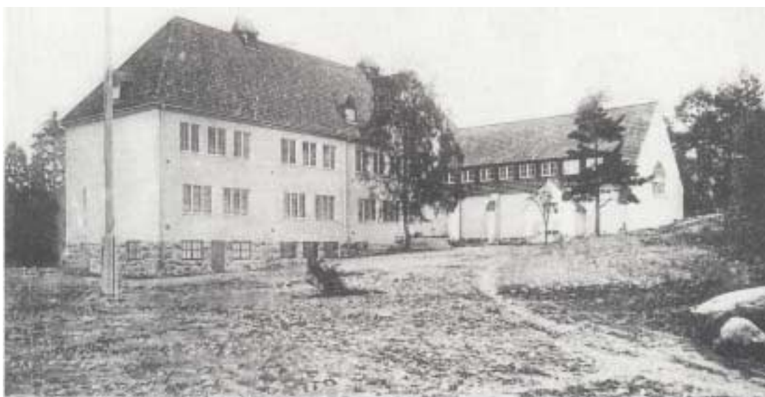
Stocksunds nuvarande skolbyggnad invigdes 1913 och byggdes sedan ut i början av 1920-talet.
